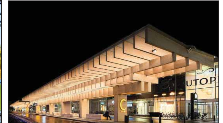
Exempel på en infrastrukturbyggnad med trästomme, Umeå station (ej BRT)
