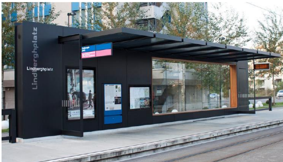
Figur 3. Bilden visar en BRT-station i stadsmiljö i Zürich, Schweiz som har flera av de funktionerna som normalt förknippas med en tågstation. (Foto: Stephan Bösch)
